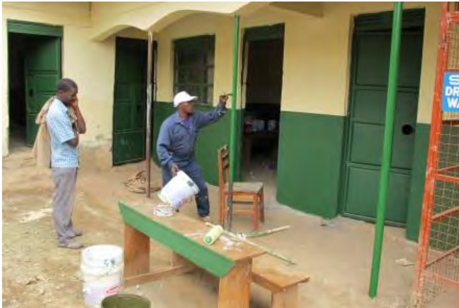
Das alte Gebäude wurde von innen und außen renoviert
